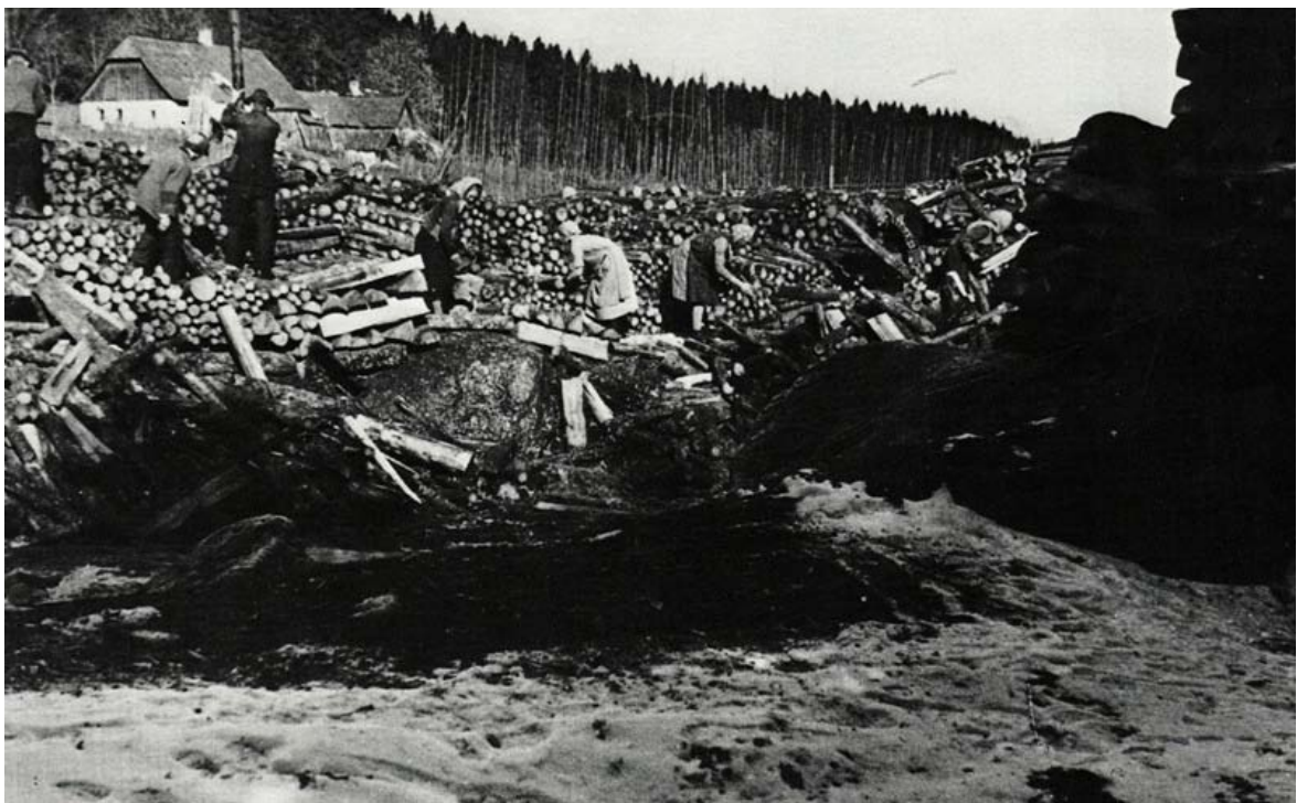
Abbildung 7 Arbeiter bei der Scheitholzschwemme am Buchersbach
